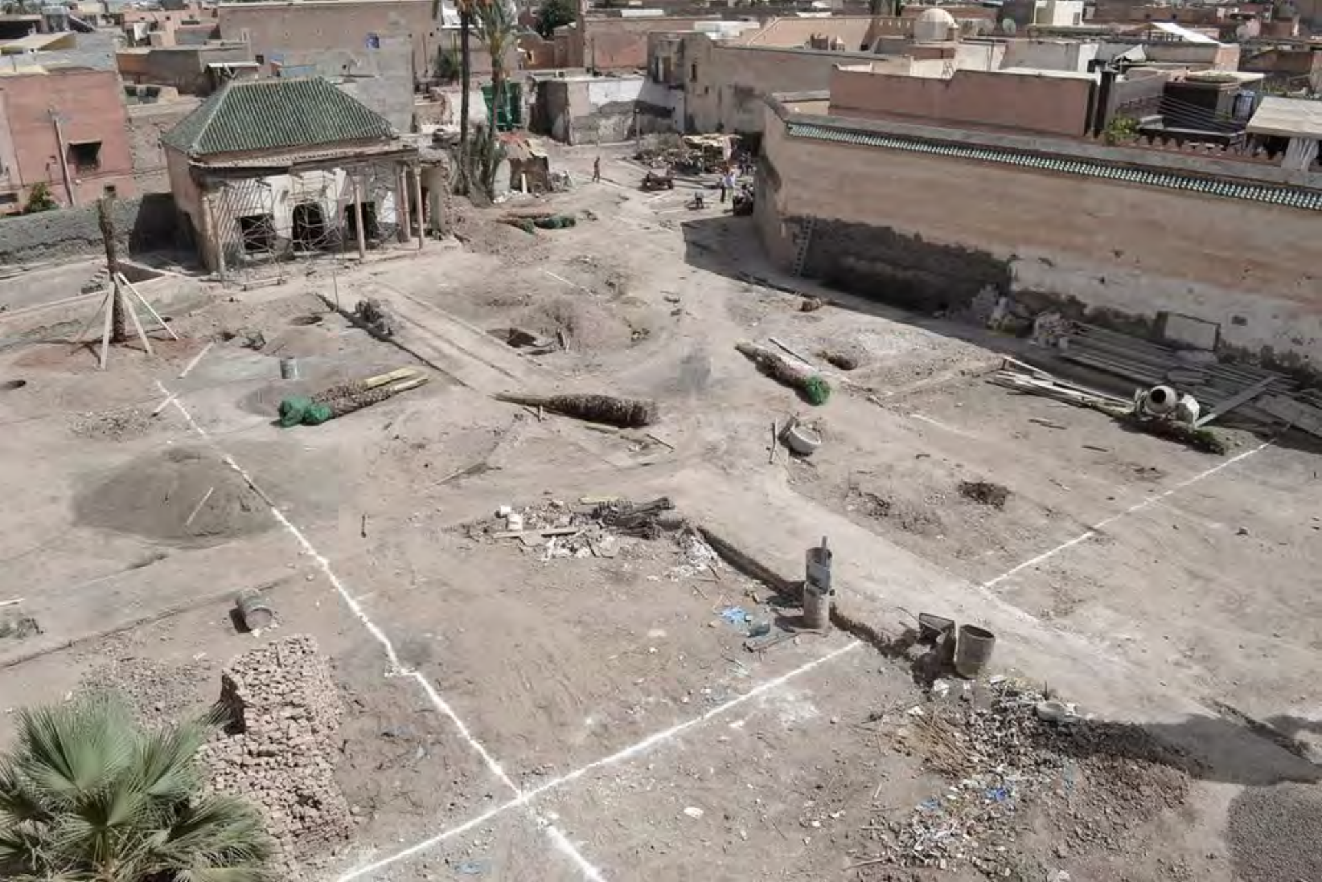
Jardin Secret, Marrakech Lavori in corso
